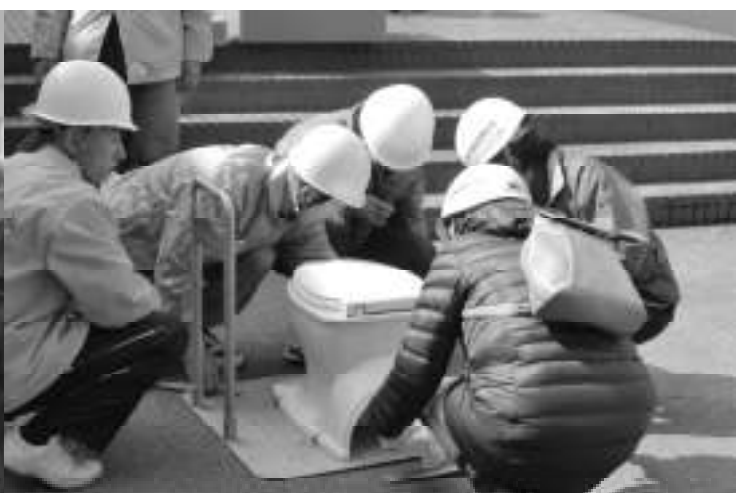
仮設トイレの組み立て
